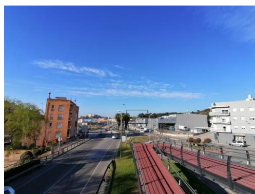
4-VISUAL DESDE PONT PEATONAL DE MAS BORINOT
